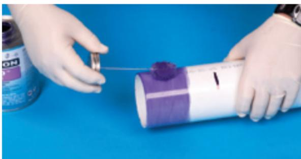
**11.** Aplique una segunda aplicación del Primer en el casquillo. No permita que el Primer se corra en el interior de la conexión o del tubo.
