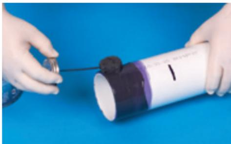
**14.** Agresivamente aplique una capa mediana de cemento en el casquillo de la conexión; evite anegar de cemento en el casquillo. El tubo de campana, no permita que el cemento corra mas allá de la campana.
