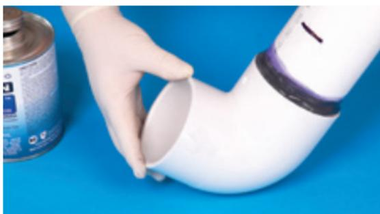
**18.** Después de ensamblar, la unión debe tener un anillo o moldura de cemento completamente alrededor de la entrada de la conexión. Si hay espacios presentes en este anillo, no fue aplicado suficiente cemento y la unión puede ser defectuosa.
