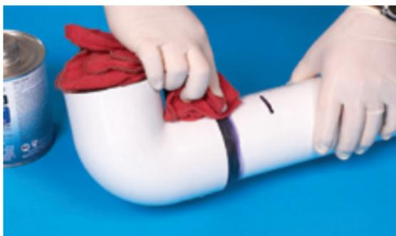
**19.** Usando un trapo, remueva el exceso de cemento de la unión incluyendo el anillo o moldura, esto ablandaría inutilmente la tubería y el accesorio y no agregaría fuerza a la unión. Exceso del cemento alrededor de la entrada de la conexión también prolongará el tiempo de fraguado. Evite mover la unión.
