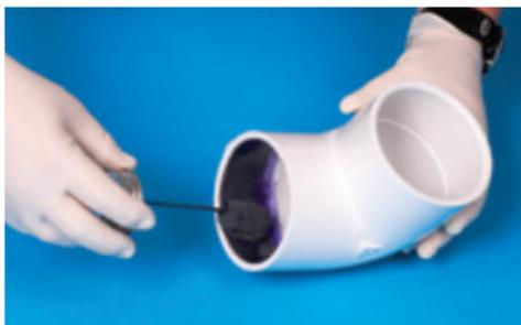
**15.** Aplique una segunda capa pareja llena de cemento en la tubería. La mayoría de las fallas de uniones son causadas por el uso escaso del cemento.
