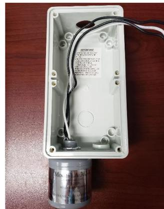
5. Conecte los cables negros del supresor en la pastilla térmica, empalmándolos con las dos fases que van al inversor y el cable blanco llévelo a neutro-tierra física.
