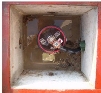
Así como en el acoplador, las conexiones en el registro son muy importantes. Es importante que la conexión en el registro sea directa al borne del electrodo, El cable no debe tener curvas o coca dentro de los registros.
