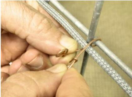
**1** Envuelva el cable alrededor del cable del sensor y la cerca.
