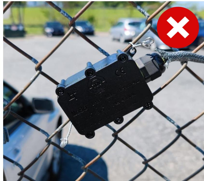
Monte el MCTR con la entrada del cable hacia el suelo. La unidad de terminación de fin de línea (MCTR) debe montarse al final de cada zona. Una zona no podrá funcionar sin una y permanecerá en alarma.
