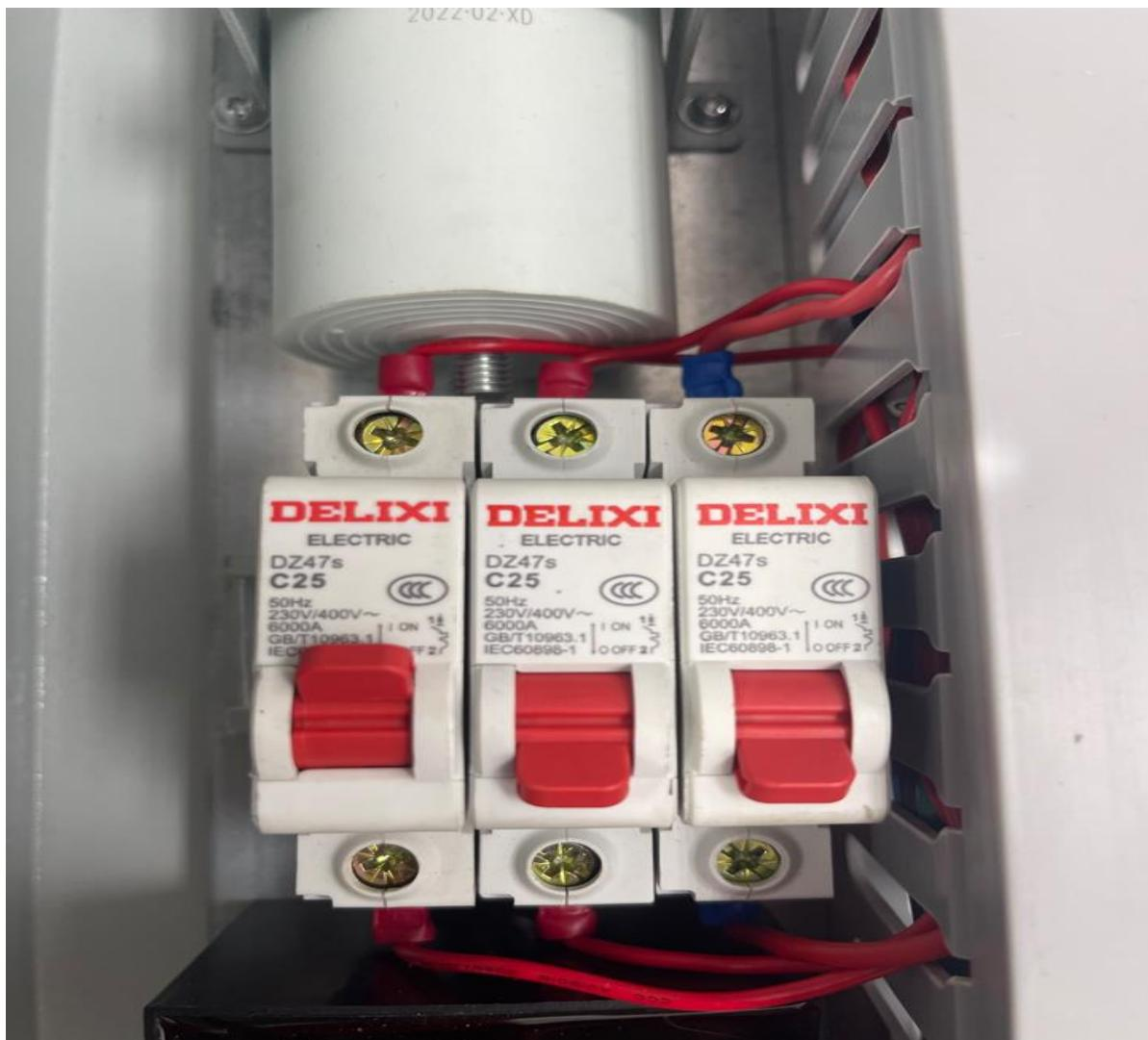
El interruptor No. 1 está encendido en estado **ON**, y el resto de interruptores deben estar apagados en estado **OFF**, esto nos permitirá trabajar con 1 solo bolardo.
