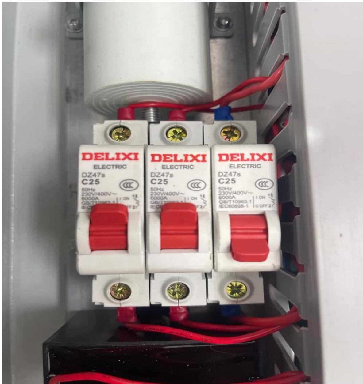
Los interruptores de emparejamiento 1 y 2 deben estar encendidos en posición de **ON** y el tercer interruptor debe estar apagado en posición **OFF**, con este emparejamiento el sistema operara con 2 bolardos.
