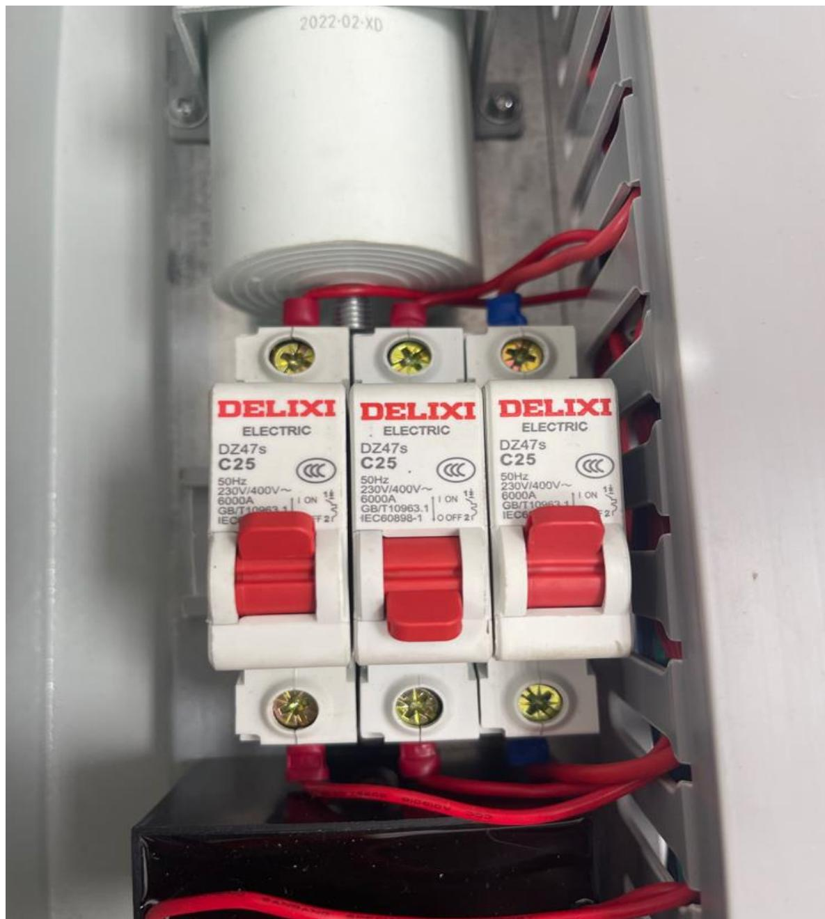
Los interruptores de emparejamiento 1 y 3 deben estar encendidos en posición de **ON** y el segundo interruptor debe estar apagado en posición **OFF**, con este emparejamiento el sistema operara con 3 bolardos.
