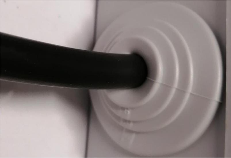
Figura 2.31 Fotografía: como pasa cable con el cable del flotador
