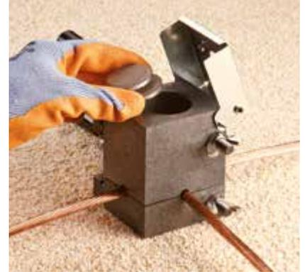
Inserte y conecte el iniciador electrónico **APLIWELD®-E**
