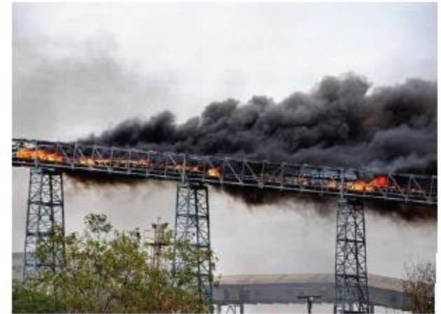
Incendio en Banda Transportadora
